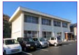
病院敷地内に有る保育所になる建物（4日撮影）
