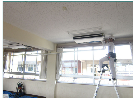
エアコンの設置作業中
